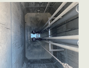
中継ポンプ槽設置例
